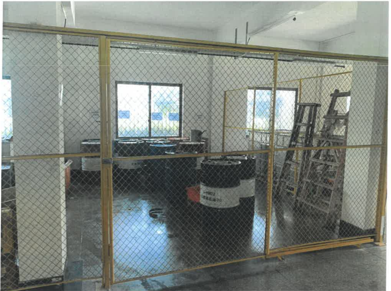
危险废物仓库
